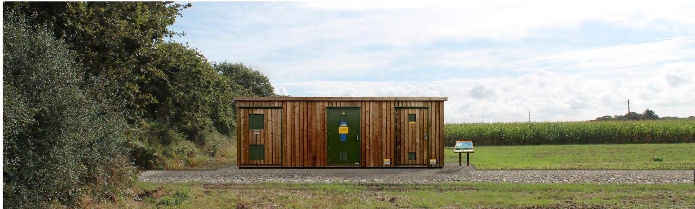
Figure 12 : Intégration du poste de livraison dans l'environnement
